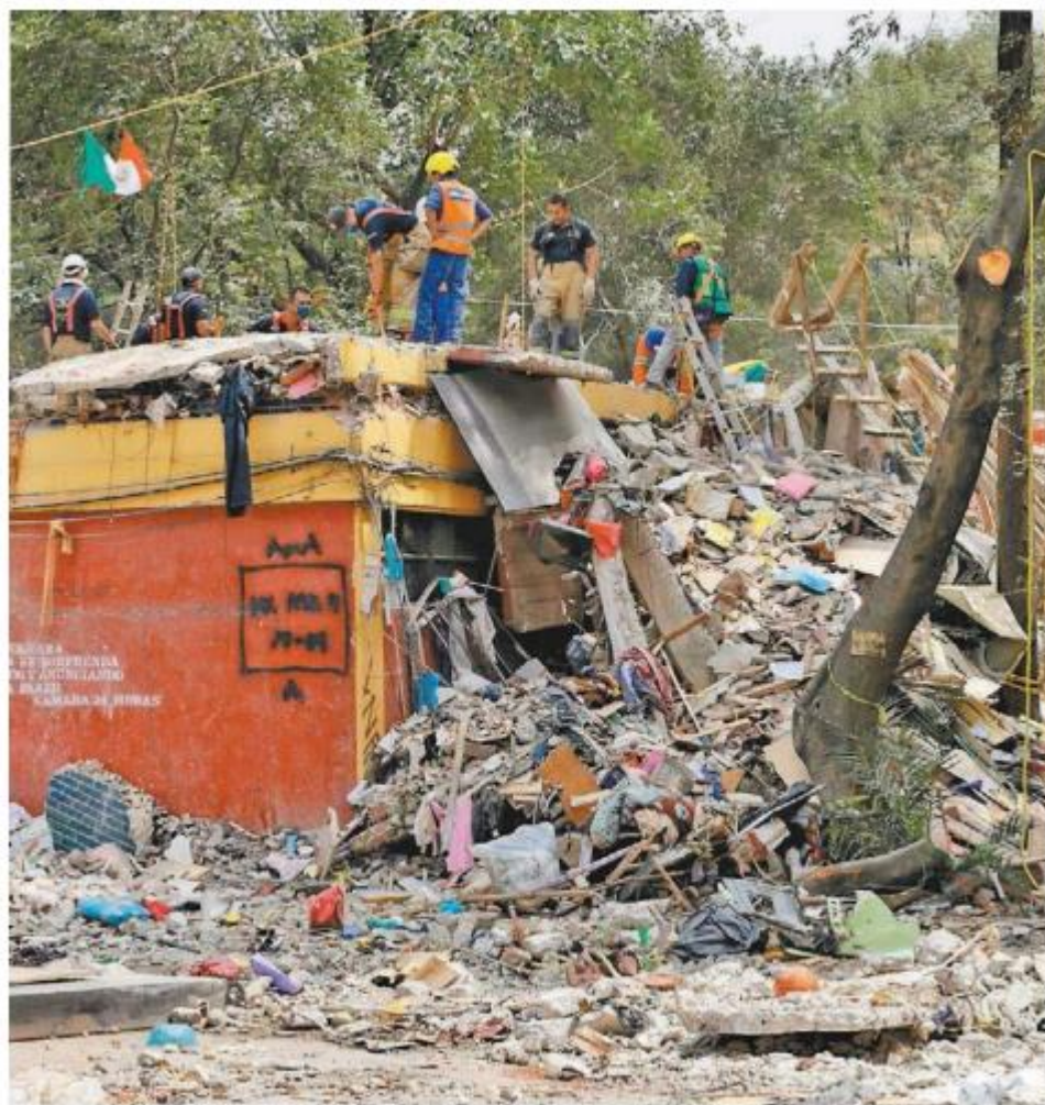
Brigadas de remoción de escombros en Tlalpan tras el sismo de 2017. JESÚSQUINTANAR
