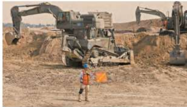
La Secretaría de la Defensa Nacional fue la encargada de edificar el nuevo aeropuerto en la zona de Santa Lucía, en el Estado de México. FOTO: EE; ARCHIVO
