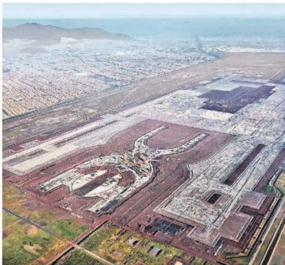
Vista aérea de la inacabada construcción. CUARTOSCURO
