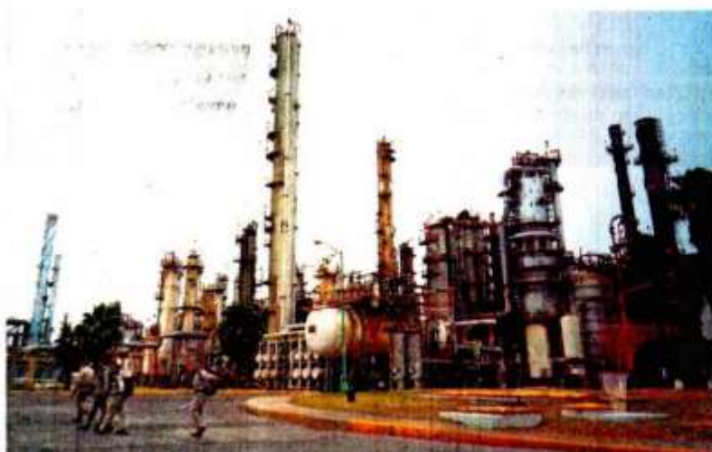
En 2023, el presupuesto de inversión para Pemex fue de 440 mil 878 millones de pesos y se prevé que para 2024 aumente a 503 mil 138 millones de pesos.
