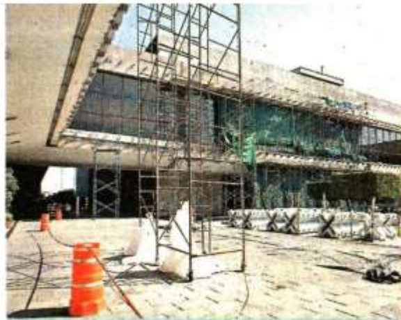
■ Trabajos de remodelación en el patio central del Palacio Legislativo de San Lázaro realizados entre 2013 y 2014.
