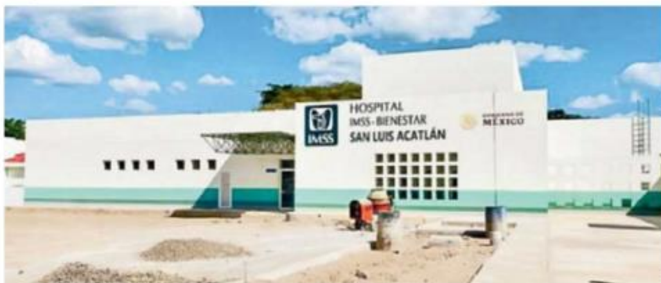
HOSPITALES. El complejo del IMSS-Bienestar en San Luis Acatlán, municipio ubicado en el estado de Guerrero, en plena construcción, el pasado 5 de abril de 2023.
