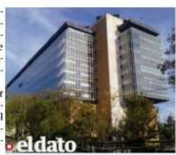
el dato El edificio de la ASF en la carretera Picacho-Ajusco cuenta con 15 niveles, que comprenden sótano, auditorio, comedor, estacionamiento y terraza, entre otras áreas.
