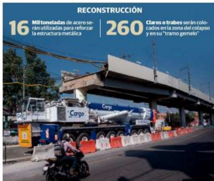
AVANZA la rehabilitación, como se aprecia en esta imagen de archivo.
