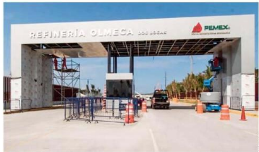
CONSTRUCCIÓN. El presidente Andrés Manuel López Obrador ha asegurado que la refinería de Dos Bocas, Tabasco, se inaugurará el 2 de julio próximo.
