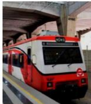
La obra tiene un avance del 21%
