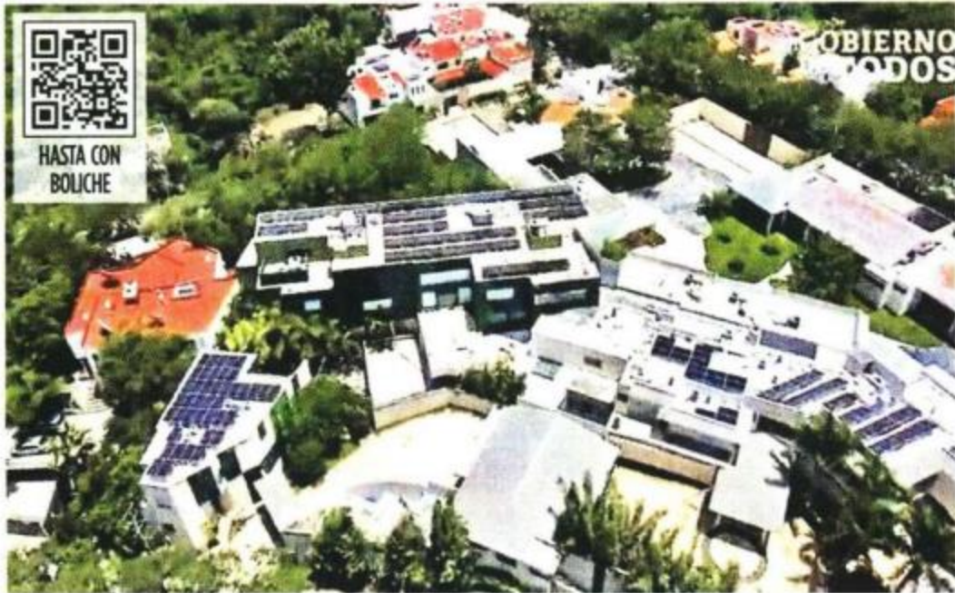
■ Vista aérea de la residencia que construyó el ex Gobernador de Campeche.
