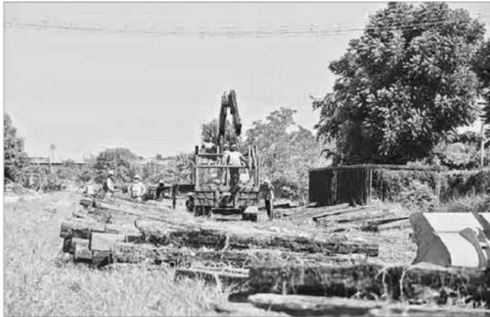
▲ "El Tren Maya es una obra extraordinaria, pero le falta planeación", advirtió el senador priísta Jorge Ramírez Marín. En la imagen, trabajos en el tramo de Campeche. Foto Lorenzo Chim
