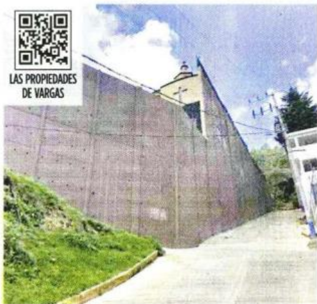
La muralla que construyó con cámaras apuntando a todos lados, en su nueva propiedad en Huixquilucan, la cual presuntamente vendió al dirigente estatal del PAN.
