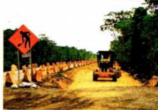
La obra del Tren Maya no se ha detenido.
