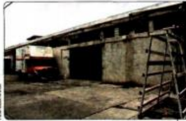
Puebla Calle 29 Poniente 2707, interior D, Col. Santa Cruz Los Ángeles Hay una bodega abandonada
