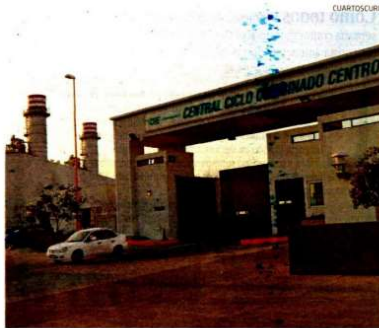
La planta de CFE en Huexca, Morelos, inaugurada tras casi una década en obra
