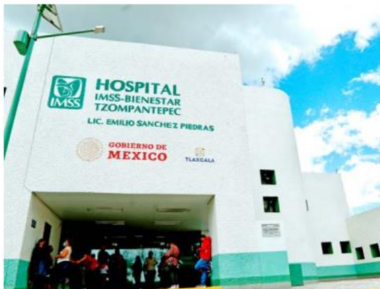
INFRAESTRUCTURA. La Unidad de Salud perteneciente al IMSS-Bienestar en el Hospital Tzompantepec de Tlaxcala, "Licenciado Emilio Sánchez Piedras".
