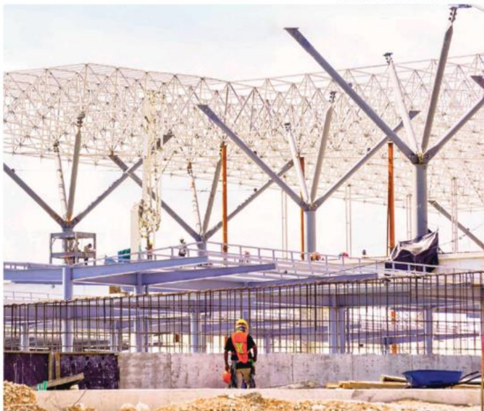
Construcción de una estación del Tren Maya en Quintana Roo
