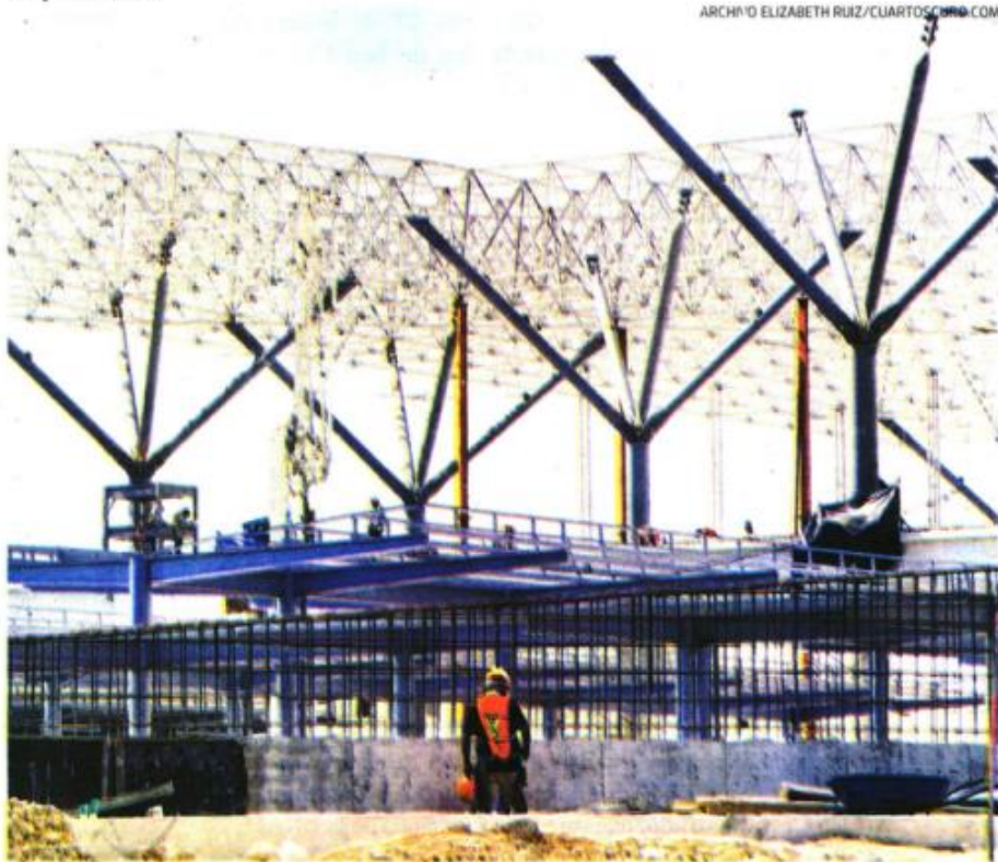
Construcción de una estación del Tren Maya
