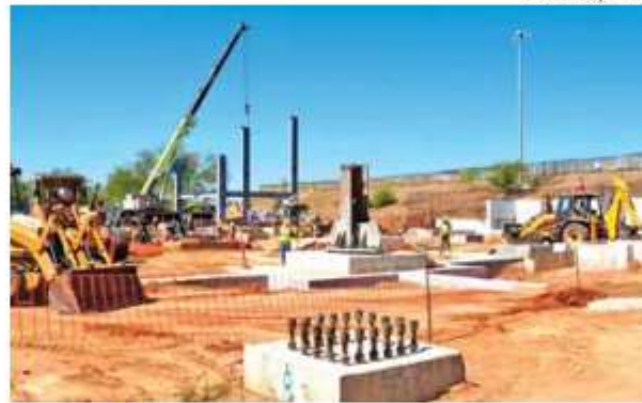
La titular del Ejecutivo supervisó las obras de la ampliación del Aeropuerto de Puerto Escondido, en Oaxaca.
