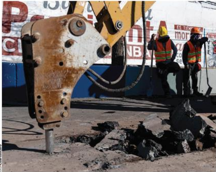
MAQUINARIA PESADA rompe el asfalto al iniciar los trabajos del también llamado Segundo Piso del Viaducto de Zacatecas, el pasado 21 de diciembre.
