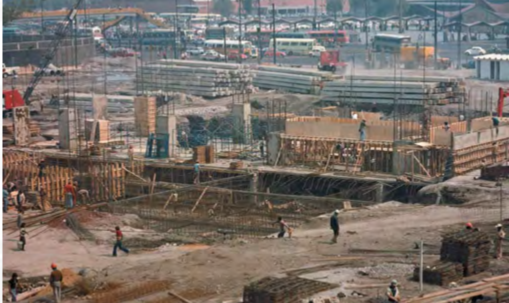
Inicia la construcción de San Lázaro.
